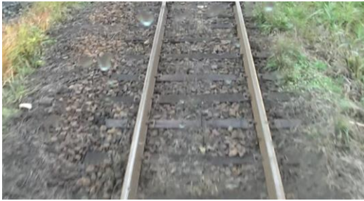
図 4. 計測開始 212 秒後に通過したバラスト軌道 (本実験環境において一般的なバラスト条件)
