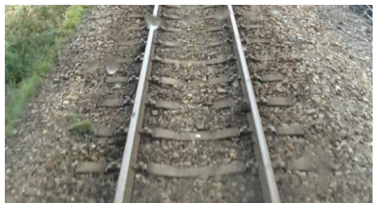
図 10. 計測開始 245 秒後に通過したバラスト軌道
